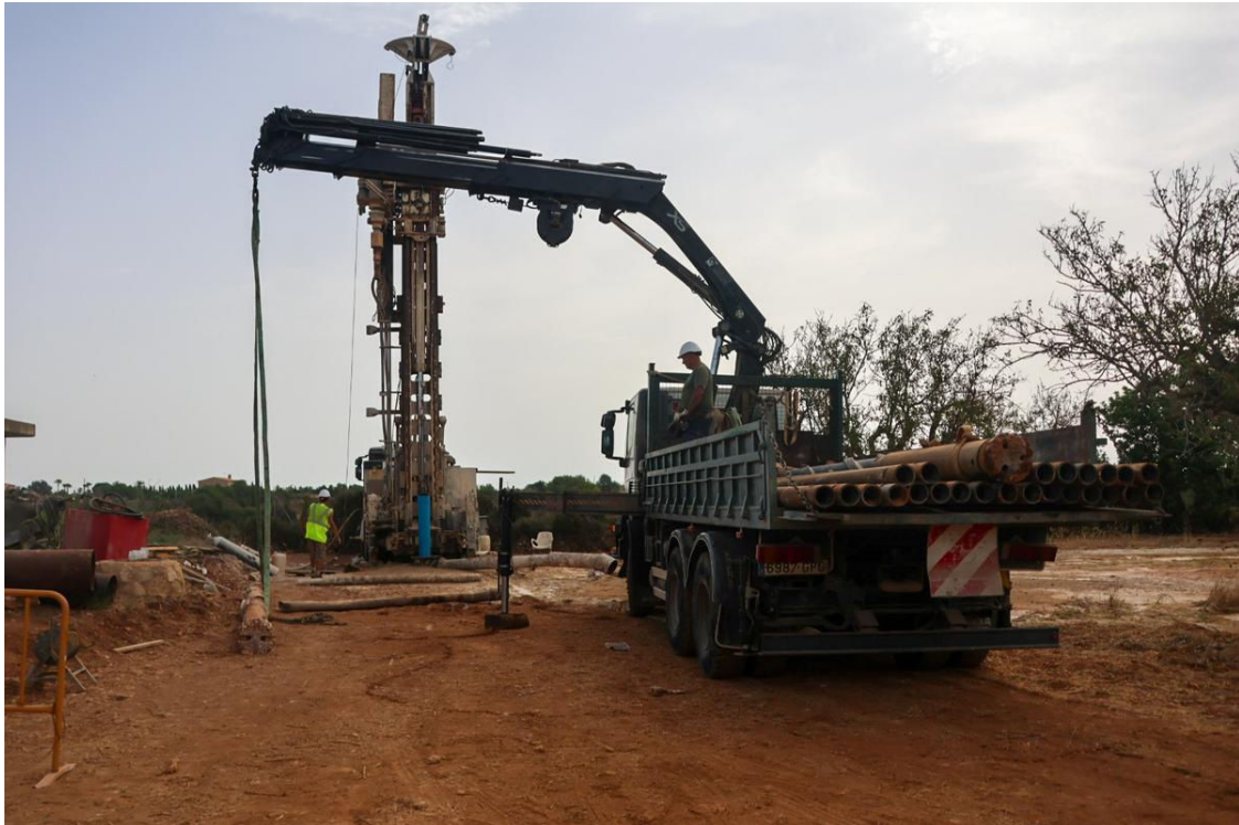
Una de las máquinas perforadoras que trabajan en sa Figuereta. / Ajuntament
