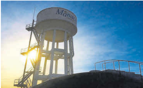
En la fotografía, un depósito de agua en Manacor.
